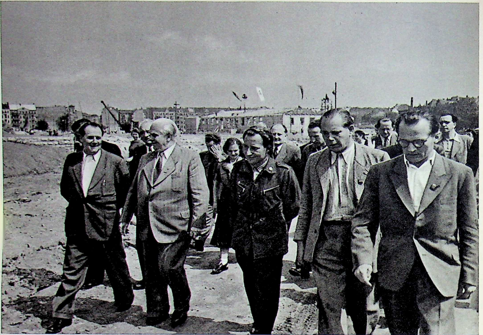
Präsident Wilhelm Pieck besichtigt die Baustelle des Sportplatzes an der Cantianstraße, des heutigen Friedrich-Ludwig-Jahn-Stadions
