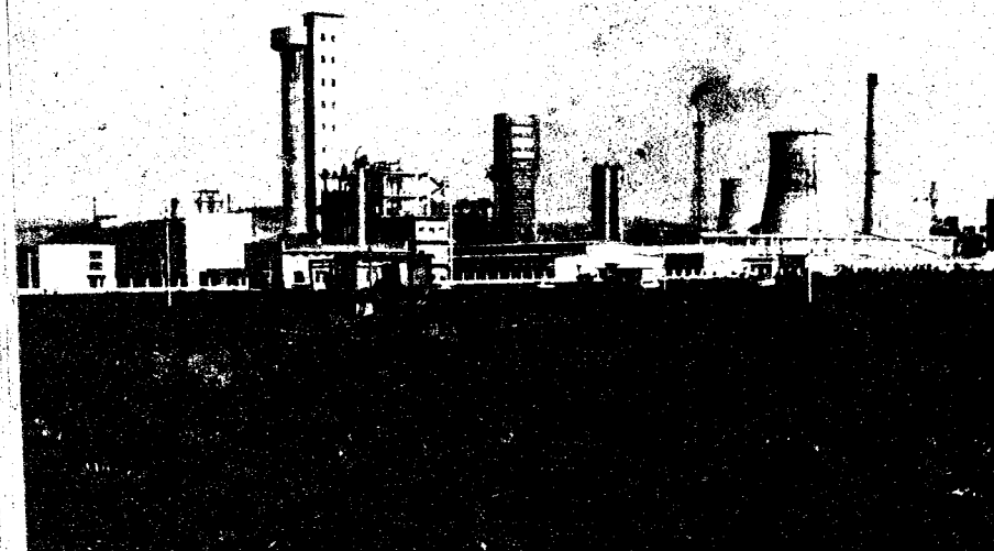
The «Gogo Nushi» nitrate ammonium plant, Fier.
