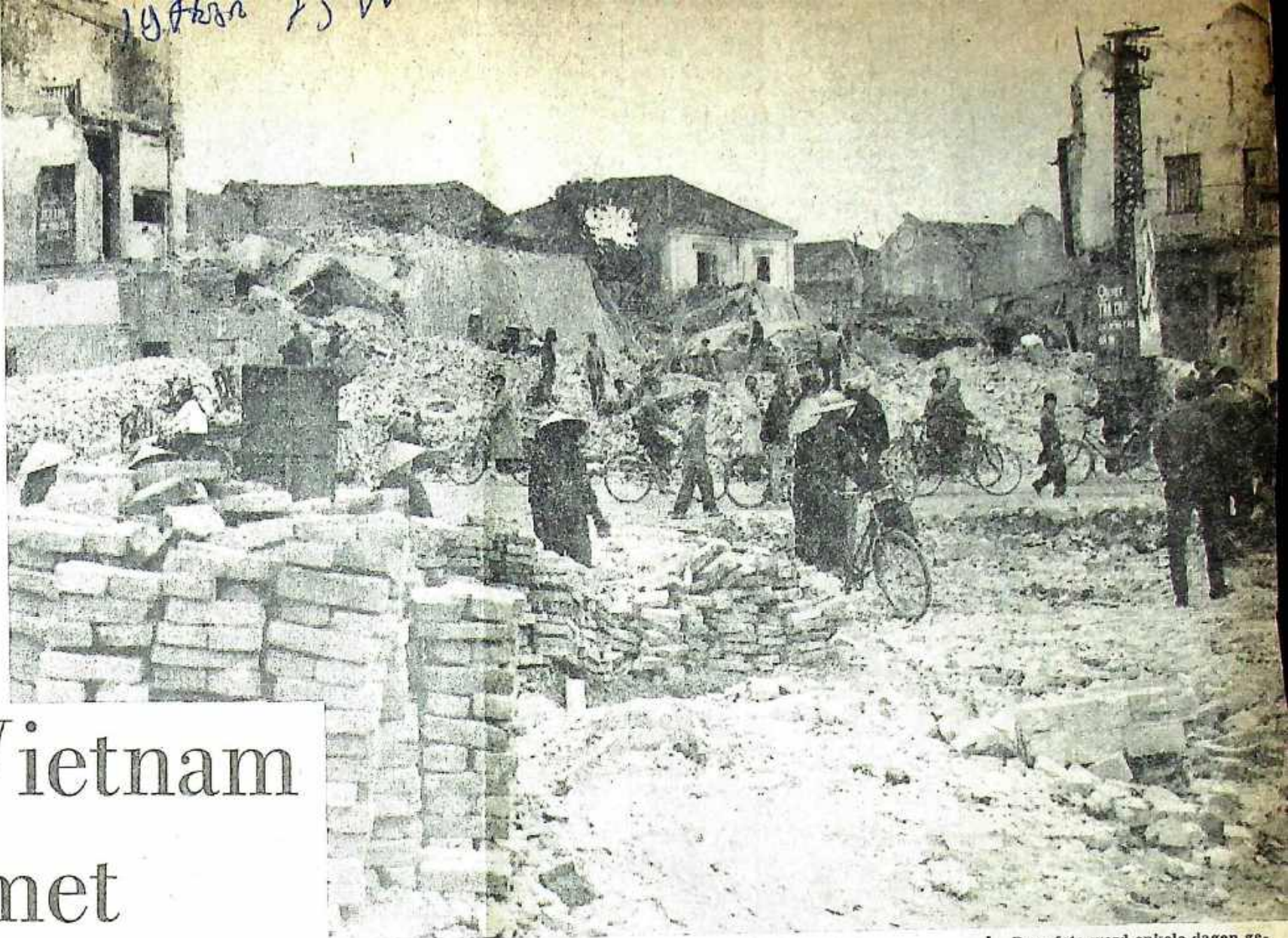
Deze foto werd enkele dagen geleden in Haiphong, de belangrijkste havenstad van Noord-Vietnam, genomen en laat zien dat de opruimingswerkzaamheden in volle gang zijn.
