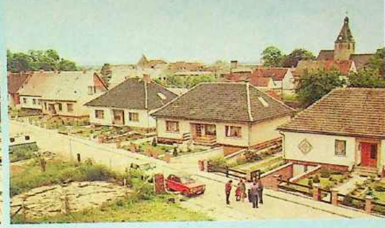
Neubau im Stil hanseatischer Backsteingotik am Universitätsplatz, einem der ältesten Plätze Rostocks
