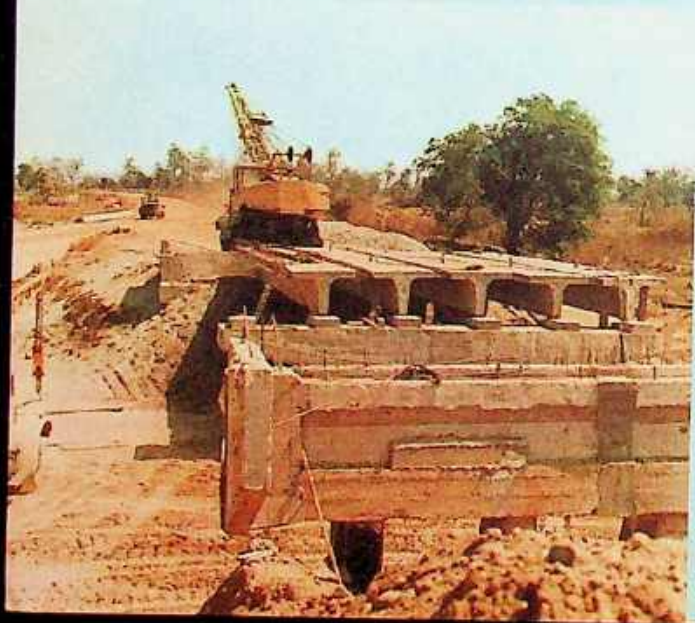
Technische Hilfe der DDR beim Straßenbau in Laos
