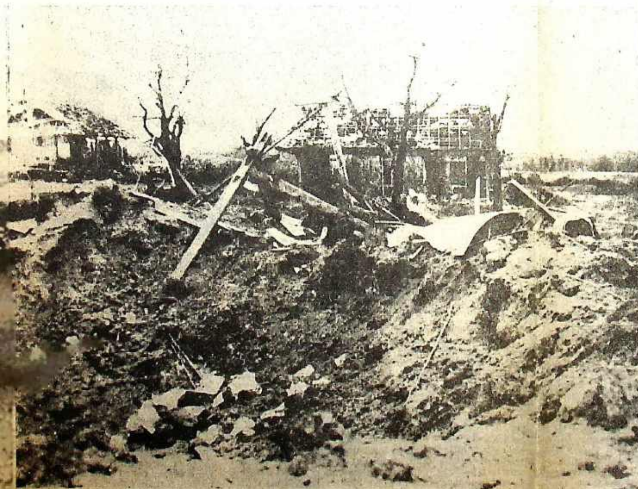
In vele delen van Noord-Vietnam worden terreuraanvallen uitgevoerd op steden en dorpen. Hier Dong Son, in de provincie Quang Binh, dat reeds een aantal keren door de vele honderden bommen geraakt is.
