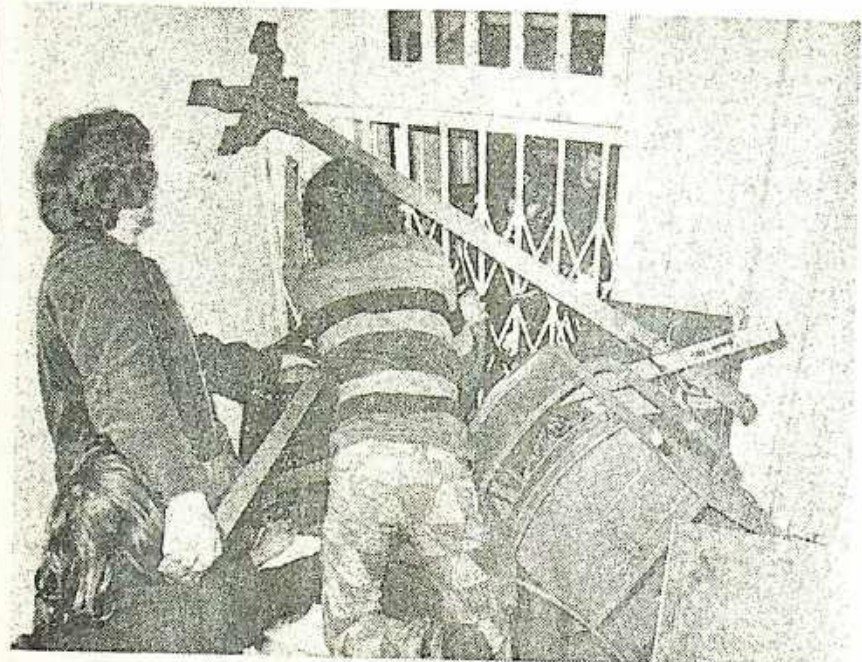
Het barricaderen van de achteringang.
