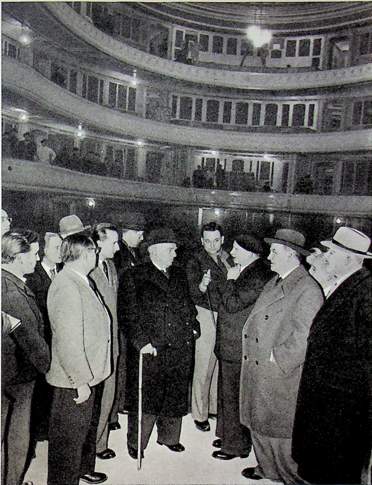
Präsident Wilhelm Pieck überzeugt sich bei einem Rundgang durch die Deutsche Staatsoper vom Fortschritt der Bauarbeiten
