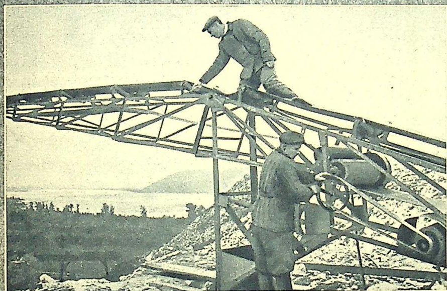
Eine Steinbrecheranlage wird montiert
