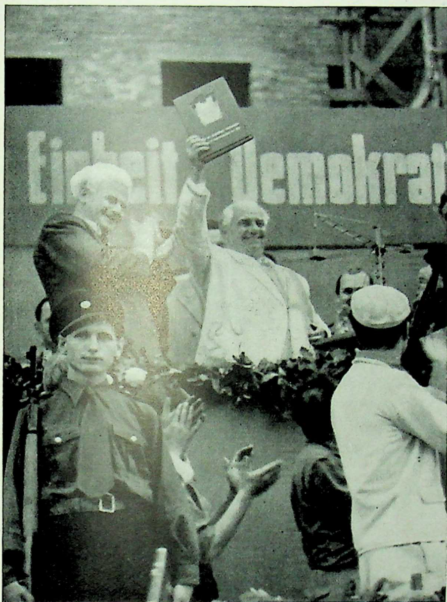
Beim Richtfest der zu Ehren der II. Parteikonferenz der SED fertiggestellten Blöcke C, E und F-Süd der Stalinallee wurde dem Präsidenten Wilhelm Pieck eine Mappe mit Selbstverpflichtungen der Bauarbeiter überreicht
