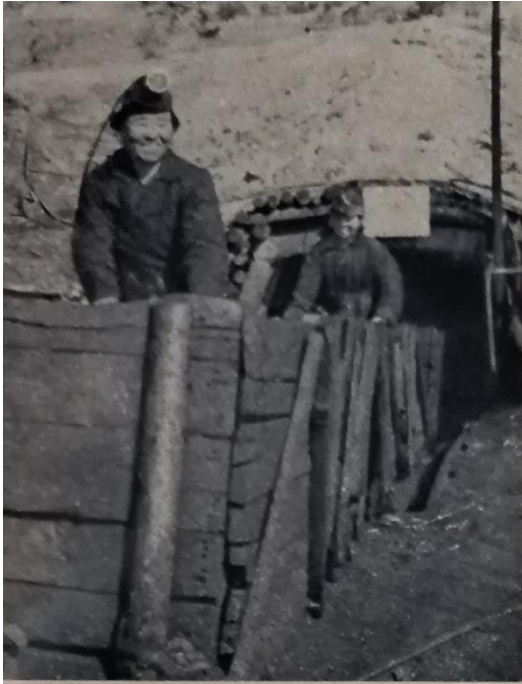
Ausfahrt aus dem Schacht
