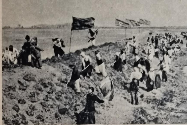
Jeder packt an. Beim Dammbau zur Gewinnung neuen Bodens
