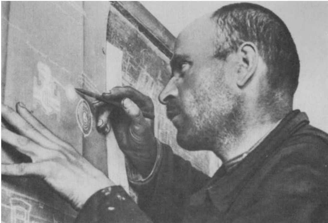
Zehntausende von Facharbeitern besuchten Abendkurse und sind dann auf Universitäten gegangen, um Ingenieur zu werden.
