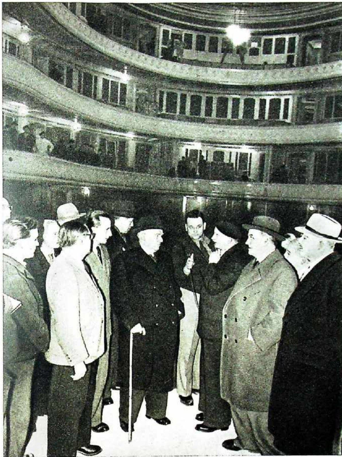
Präsident Wilhelm Pieck überzeugt sich bei einem Rundgang durch die Deutsche Staatsoper vom Fortschritt der Bauarbeiten
