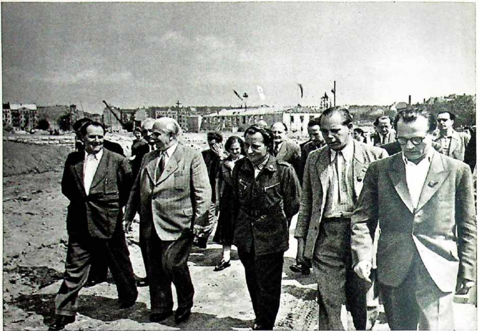
Präsident Wilhelm Pieck besichtigt die Baustelle des Sportplatzes an der Carvianstraße, des heutigen Friedrich-Ludwig-Jahn-Stadions
