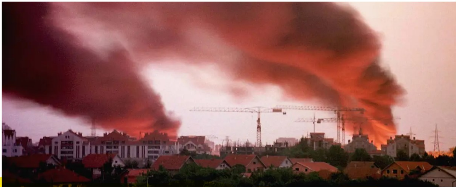
Die Nato bombardiert 1999 auch zivile Infrastruktur. Im Bild brennende Transformatorstationen in Belgrad. (Bild: AP)
